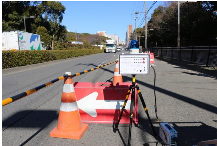
写真-3 ドレミ現場使用状況
